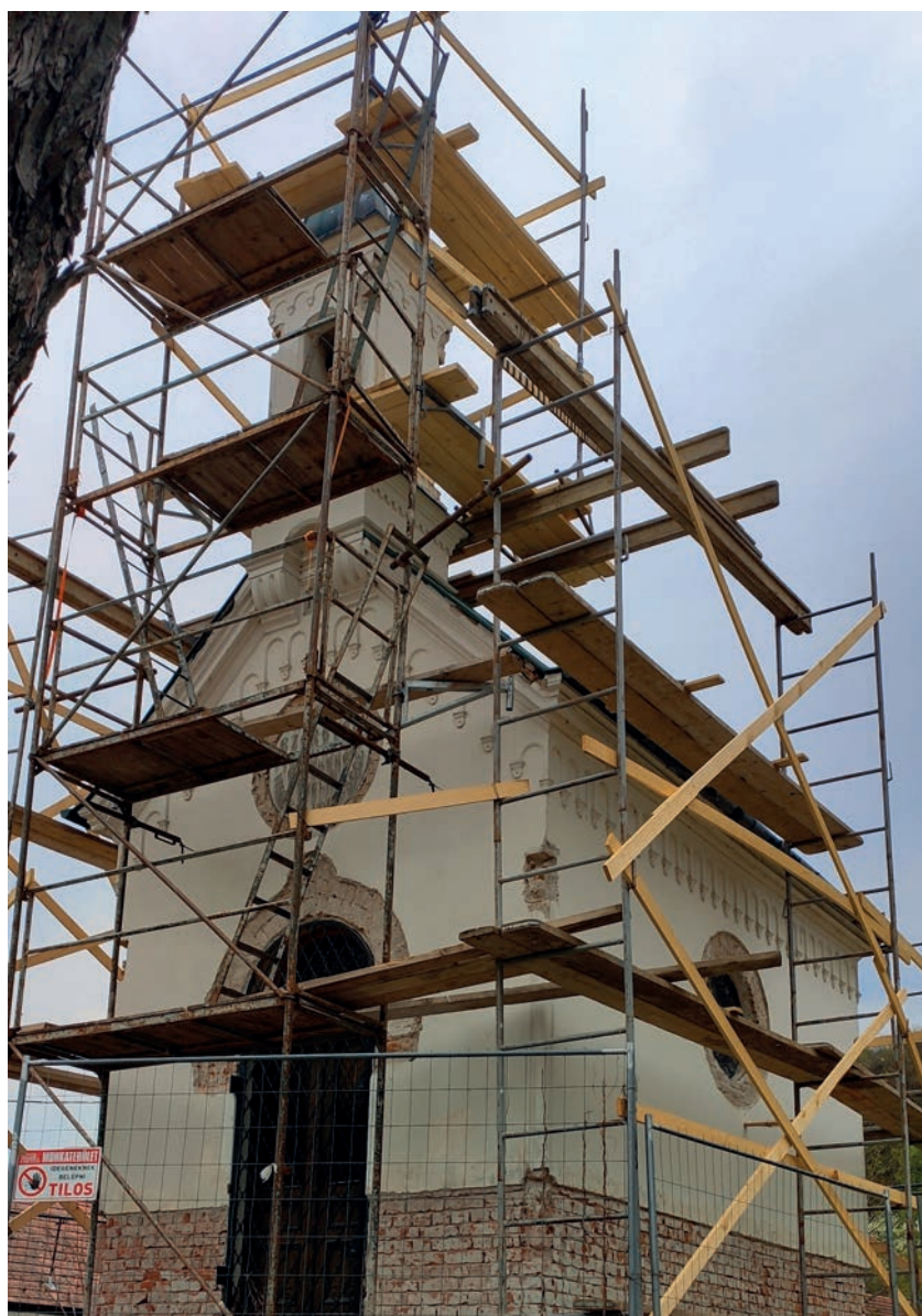
A Millenniumi kápolna felújítás közben
