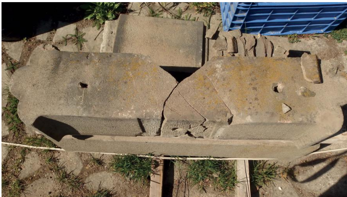
A töredékek visszaragasztását követően minden elem meg lett tisztítva a kiegészítéshez. A kiegészítő anyag a kereszttel azonos Dunabogdányi kő őrlemény és cement 3:1-es arányú Plextolos (festék emulzió keverékével).
