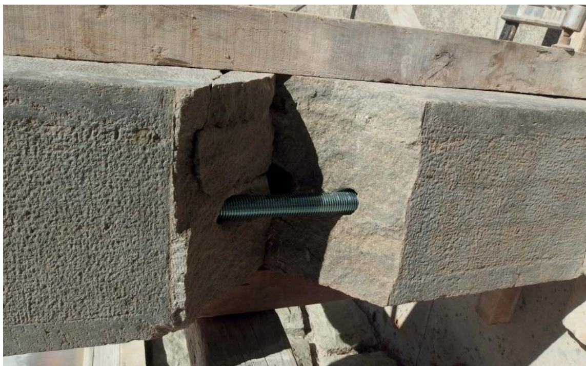
Szerencsére sok apró töredék megmaradt és a kereszt vízszintes elemét rozsdamentes csapolással még meg lehetett menteni és így nem kellett újra faragni, mint a hiányzó elveszett elemet.
